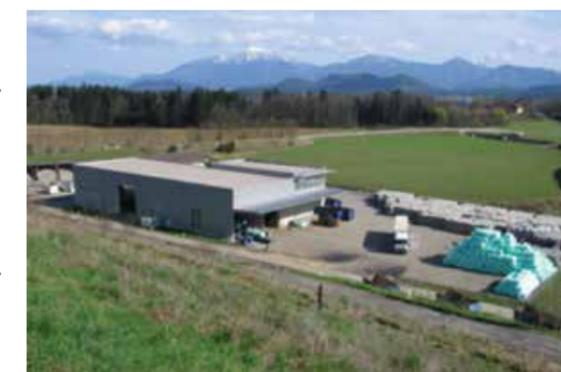
**Deponie in Tainach:** Der gesammelte Haus- und Sperrmüll kommt zunächst in die Transferstation am Gelände der Deponie Tainach und wird dort gewogen, geschreddert und gesplittet.
