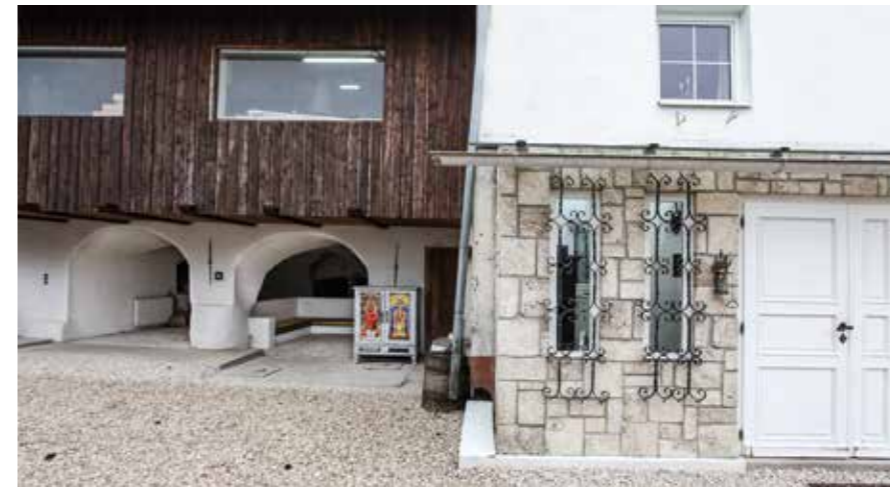
Zeitraubende Sanierung: Büromöglichkeit im unteren Bereich (in den Tufffels hinein gebaut) und darüber die Werkstatt.
